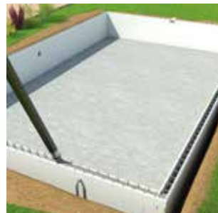
Coulage du béton dans les alvéoles.
