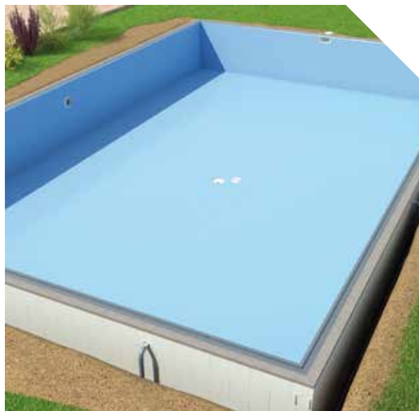
Mise en place du liner.
