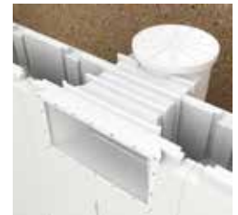
Mise en place du skimmer.
