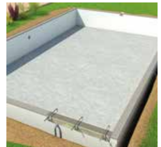
Réalisation de l'arase.
