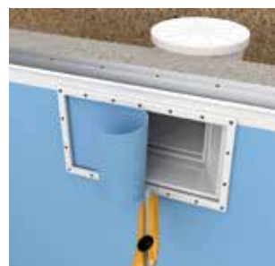
Étanchéité au droit du skimmer.
