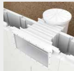
Mise en place du skimmer.
