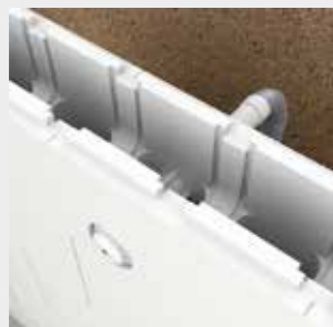
Installation des buses de refoulement et de la prise balai.
