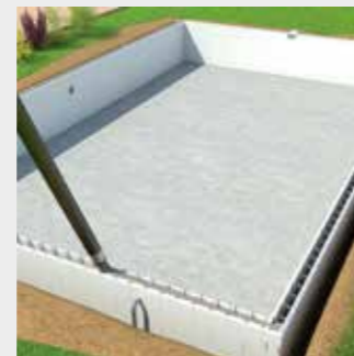
Coulage du béton dans les alvéoles.
