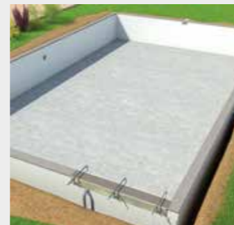
Réalisation de l'arase.
