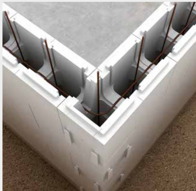
Mise en place des armatures verticales.
