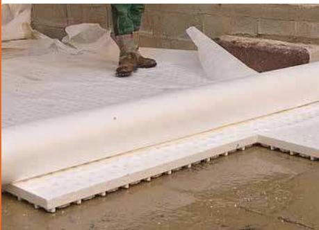
**Nota :** Les plaques doivent être accompagnées d'une couche filtrante géotextile ayant les caractéristiques suivantes :
