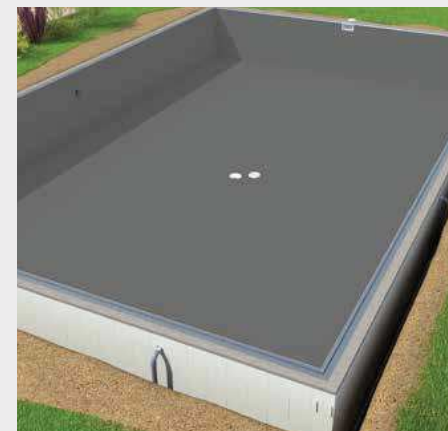
Mise en place du liner.
