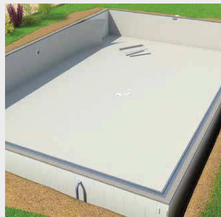
Mise en place du feutre de protection et fixation du rail de liner sur l'arase.
