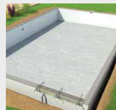
Réalisation de l'arase.
