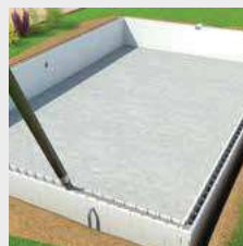
Coulage du béton dans les alvéoles.
